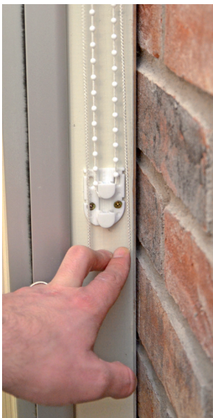
5. Ota ketjun paino pois. Laita ketju alempaan kohtaan.
