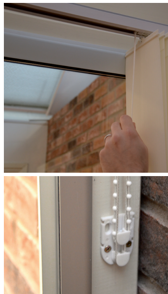
6. Vedä kaikki lamellit siten, että ne ovat suljetussa asennossa. Vedä sitten solmu ensimmäisen lamellin eteen, siihen asti kunnes ketju on kunnolla kiristetty ks. alempi kuva.
