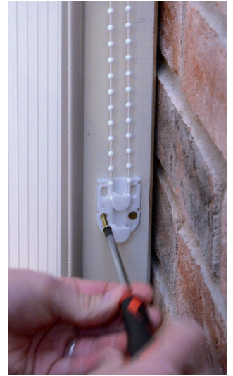
4. Ruuvaa kiinni varmuuskappale yhdessä ylemmän ketjun kanssa. Varmista, että ketju on kunnolla kiristetty.
